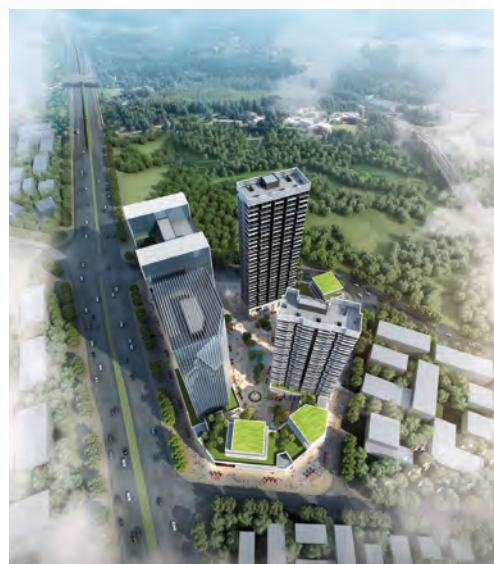
Shenzhen Dachitdat Project
